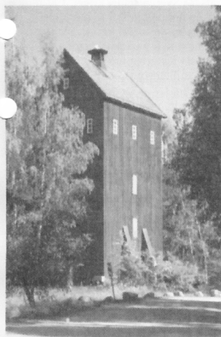
Vattentornet byggdes samtidigt med kanslihus och gymnastiksal 1929, med en borrhälsbrunn i tornet. På grund av att sjövattnet kom in i lärt vattentornet ha haft mycket dålig kvalitet. Ganska nyligen renoverat. För stå kvar till eftervärlden. Foto Lars Fors.
