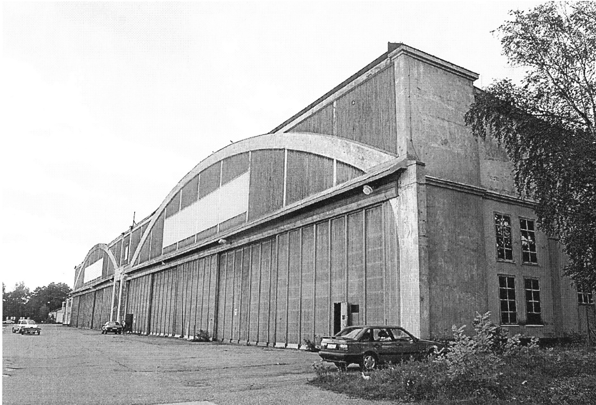
Hangar 1 NORRAN 39/970914 foto Stefan Källstigen F2 Hägernäs Kulturhusens dag med sjöhangarena
